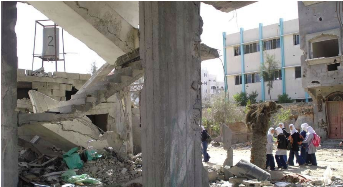
Restos de la casa de dos pisos donde murieron asesinadas Randa Salha, sus cuatro hijos y su hermana
